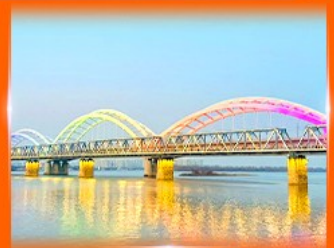
สะพานรถไฟปินโจว
